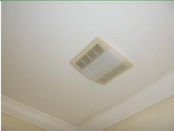
Exhaust Fan Light Out
