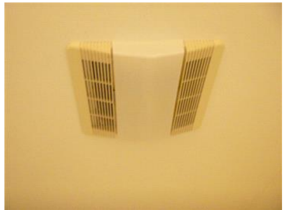
Exhaust Fan Light Out
