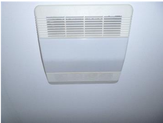
Exhaust Fan Light Out
